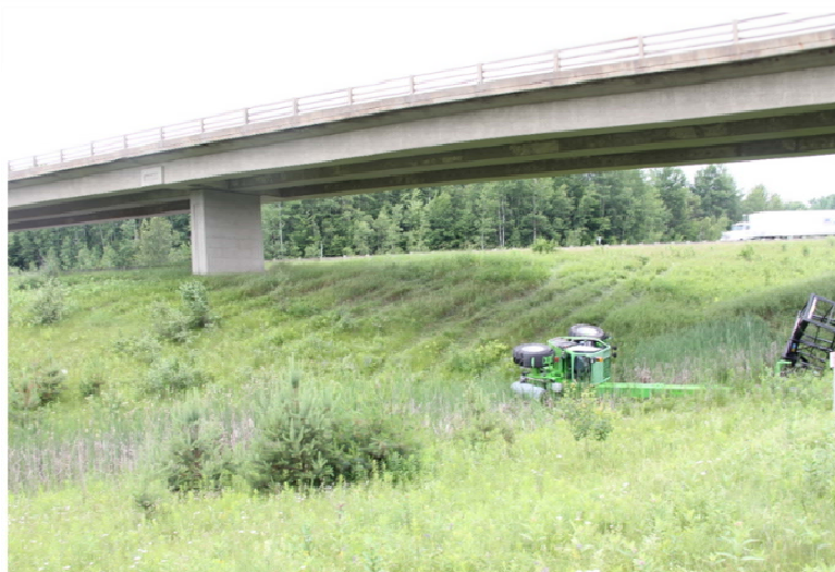
Figure 20 et figure 21 : Partie de l'itinéraire parcourue par le véhicule Merlo lors de l'inspection du pont P-14635 le jour de l'accident (Source : CSST)
